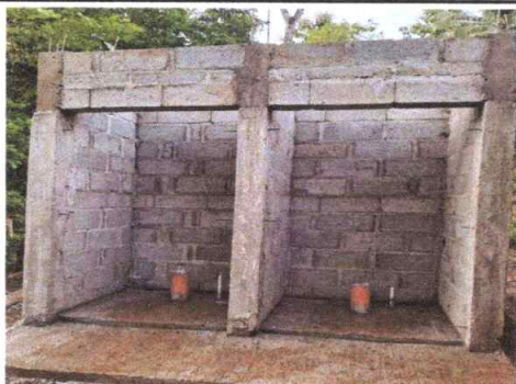
Foto 5: Evidencia del proceso de sustitucion de el sanitario lavable.
