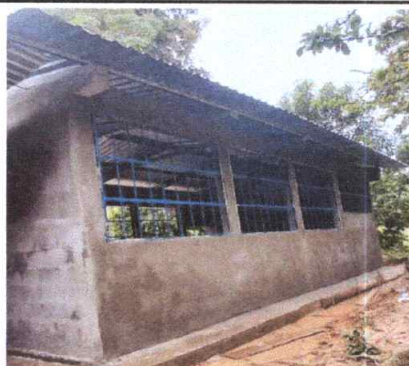
Foto 4: En la imagen se logra evidenciar donde se instalaran los balcones.
