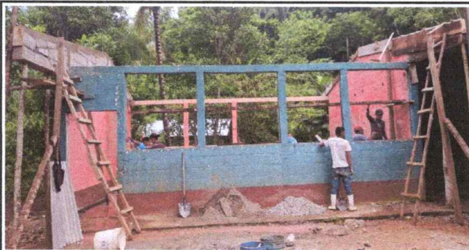
Foto1: Evidencia del proceso del techo de la escuela, se observa que se añadio unas hiladas de block en la estructura del techo.
