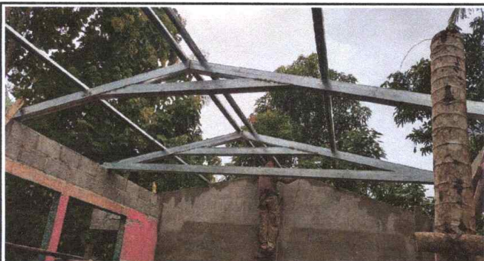
Foto 3: Proceso de instalacion de la estructura de metal del establecimiento.
